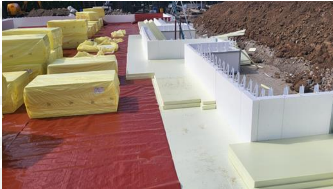
Posa sistema Platea Calda
