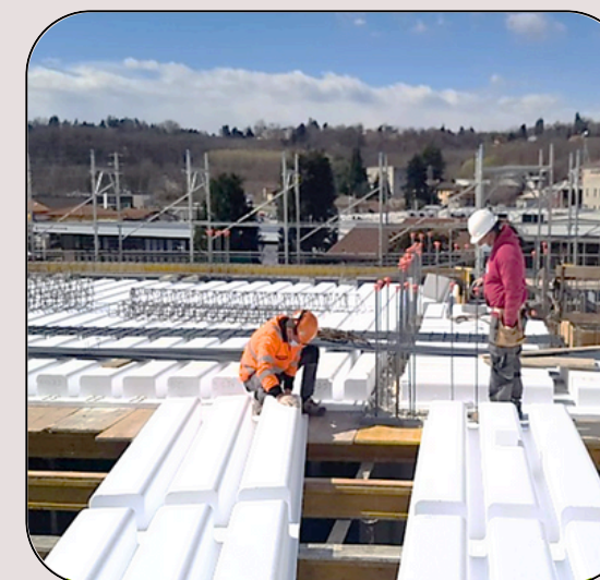
Perfettamente su misura. Ogni pannello è posato agevolmente da tre addetti
