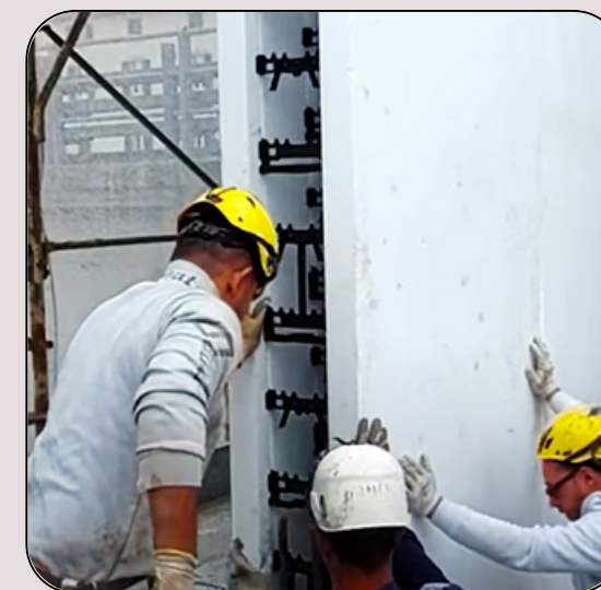
Ogni pannello è posato agevolmente da tre addetti
