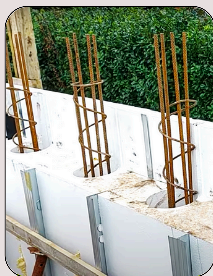
Parete a telaio = con pilastri portanti
