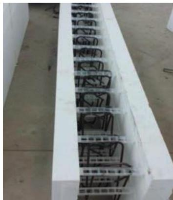
Il sistema costruttivo W4GW è sostituito da cassette realizzate con pannellature in EPS (polistirene espanso sinterizzato) collegati con appositi connettori in polipropilene. Questi cassette verranno poi completati gettando all'interno del cemento armato.
